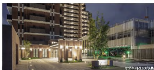
サブエントランス写真
